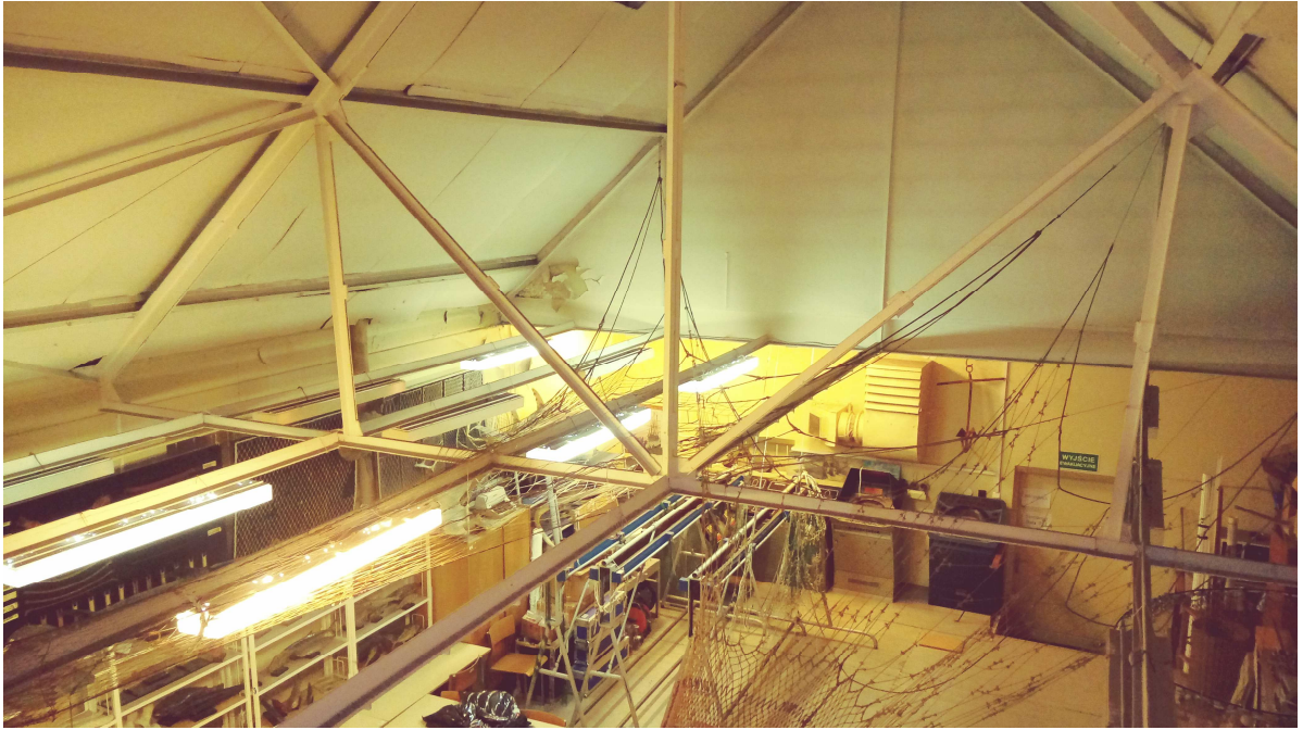
Z.10 Widok dachu i jego konstrukcji od wewnątrz, widoczna kratownica stal.
