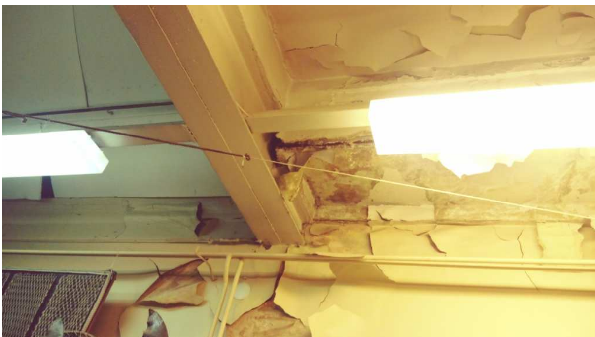
Z.14 Uszkodzenia spowodowane przez przecieki w korytach kablowych
