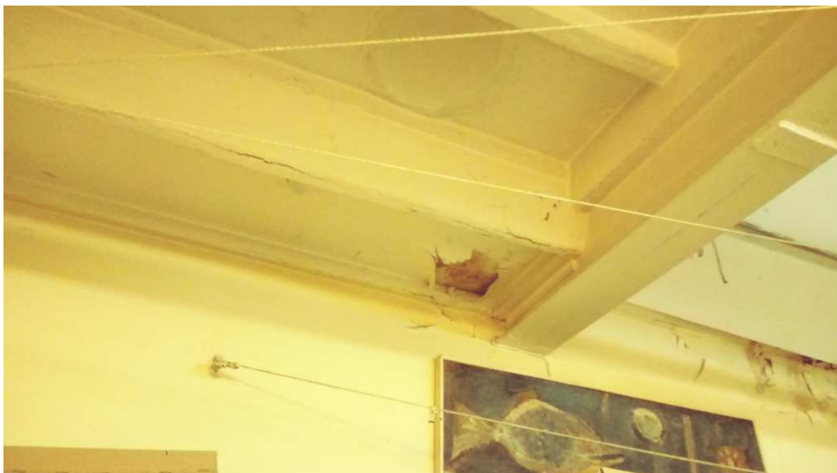
Z.13 Uszkodzenia spowodowane przez przecieki w korytach kablowych
